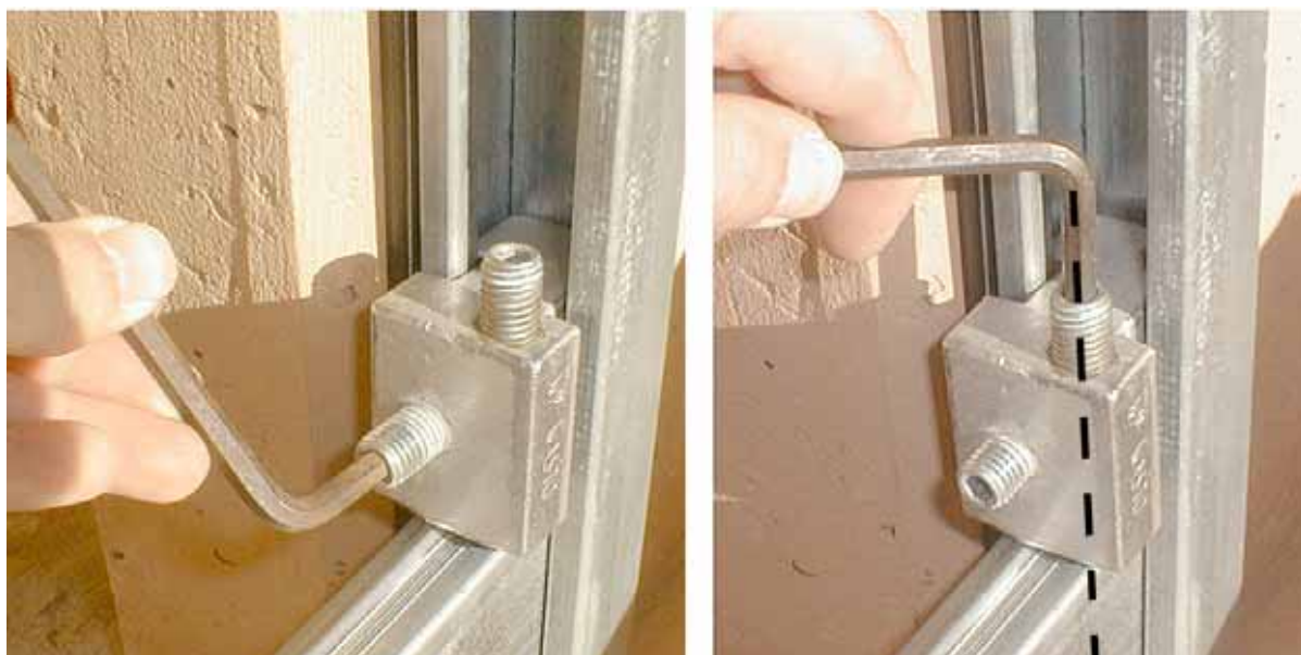
Ilustracja 2. 5: Zakładanie elementów zaciskowych i ściskanie wstępne uszczelek lamelowych.
